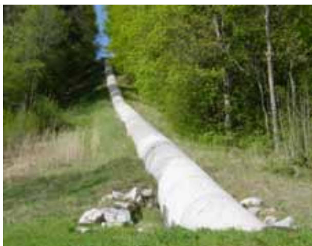
Figure II.4.21. Exemple de conduite forcée partiellement enterrée
