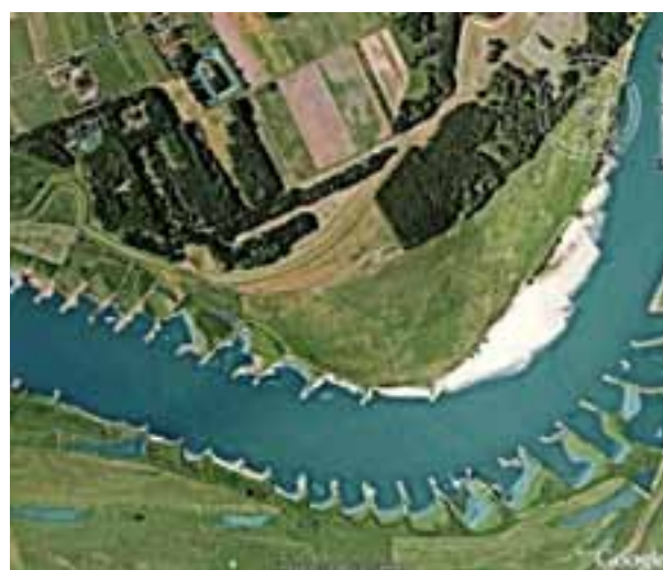
Figure II.4.35. Un système d'épis sur l'Elbe au kilomètre 477. La berge de graviers à l'intérieur ne gêne pas la navigation.
