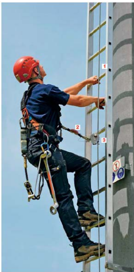
Figura 16 Persona munita di imbracatura anticaduta su un dispositivo di tipo guidato.
