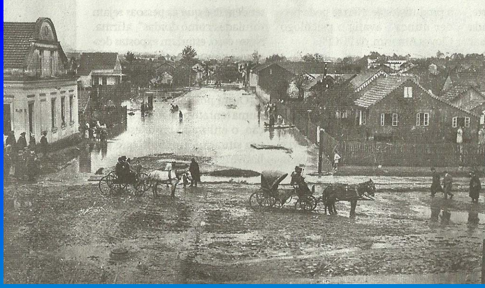
Outubro de 1911: a enchente dos rios do Ivo e Belém atinge a Rua João Negrão. Foto tirada do alto da Ponte Preta.
